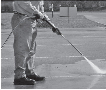
Figura 12 - Mejor ángulo de limpieza de superficies
