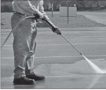
Figura 11 - Mejor ángulo de limpieza de superficies
